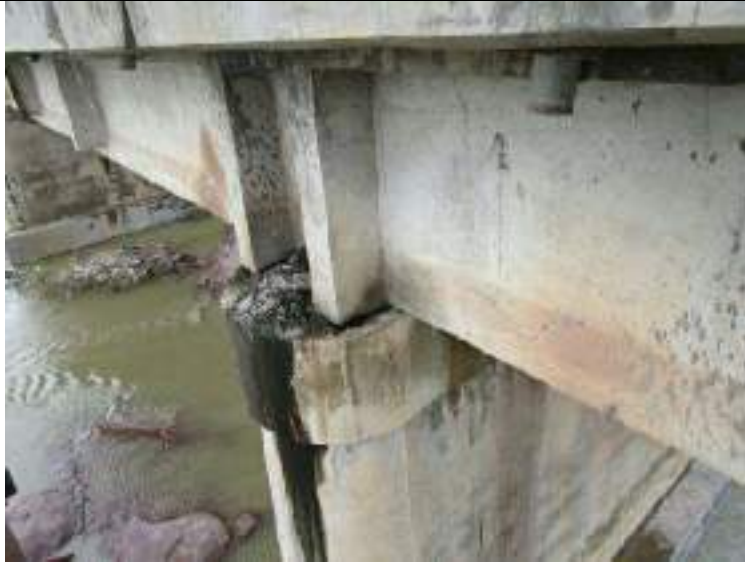
Pic - 8. 1 : Pier Damage Images
