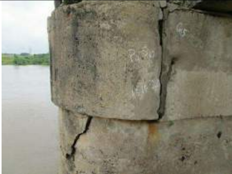
Pic - 8. 0 : Pier Damage Images
