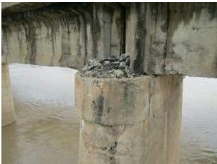
Pic - 8. 1 : Pier Damage Images
