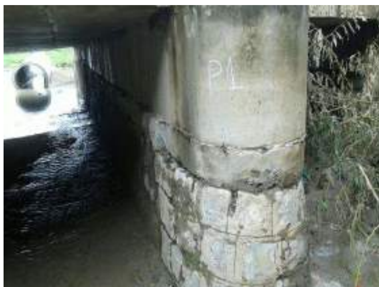
Pic - 6. 1 : Pier Damage Images
