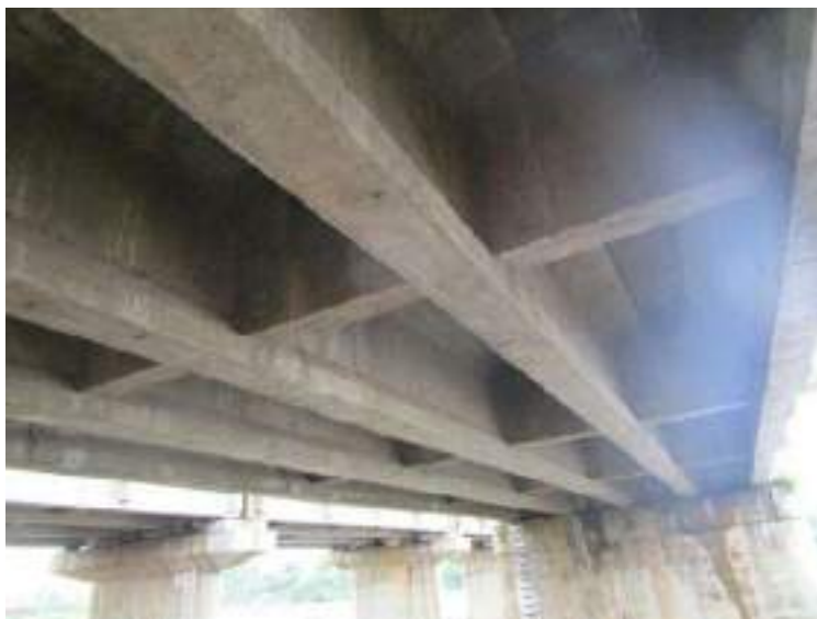
Pic - 4. 2 : Type of Superstructure
