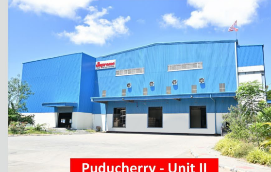
Puducherry - Unit II
