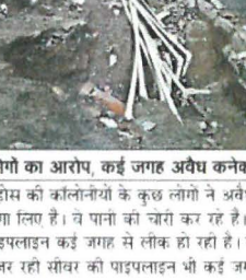
लोगों का आरोप, कई जगह अवैध कनेक्शन बनाए पड़ोस की कॉलोनीयों के कुछ लोगों ने अवैध कनेक्शन लगा लिए हैं। व पानी की चोरी कर रहे हैं। इस कारण पाइपलाइन कई जगह से लीक हो रही है। बगल से ही गुजर रही सीवर की पाइपलाइन भी कई जगह से लीक
