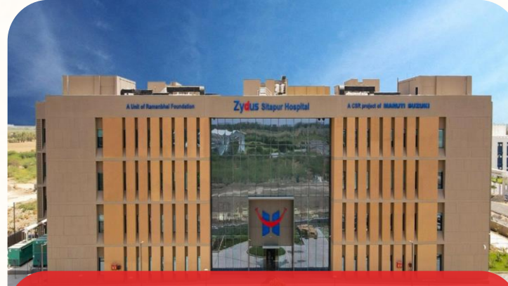
Zydus Hospital Sitapur (Epc Project)
