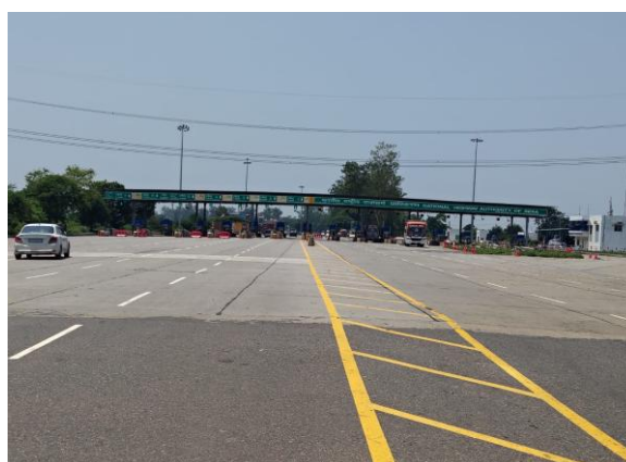
Maigalganj Toll Plaza
