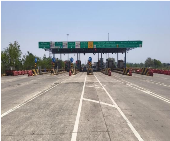
Mohtara Toll Plaza
