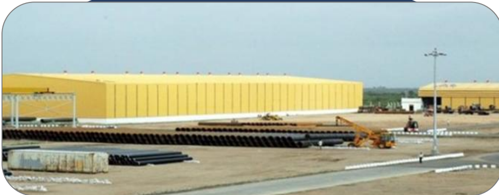
Anjar Plant, Gujarat
