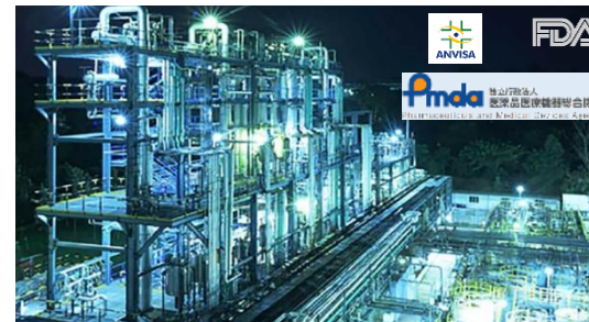
Nanjangud, Karnataka, India - CDMO API
