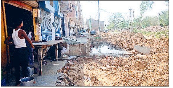
आदमपुर। जवाहर नगर साइड में रेलवे द्वारा बनाई जा रही दीवार के मध्य की गई खुदाई तथा टूटी पाइपलाइन
