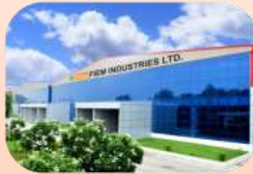
Unit-8, Tapukara (Rajasthan)
