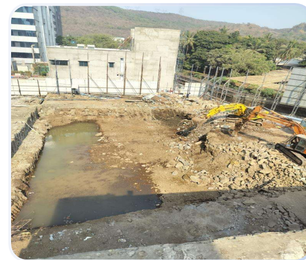
Actual Site Image
