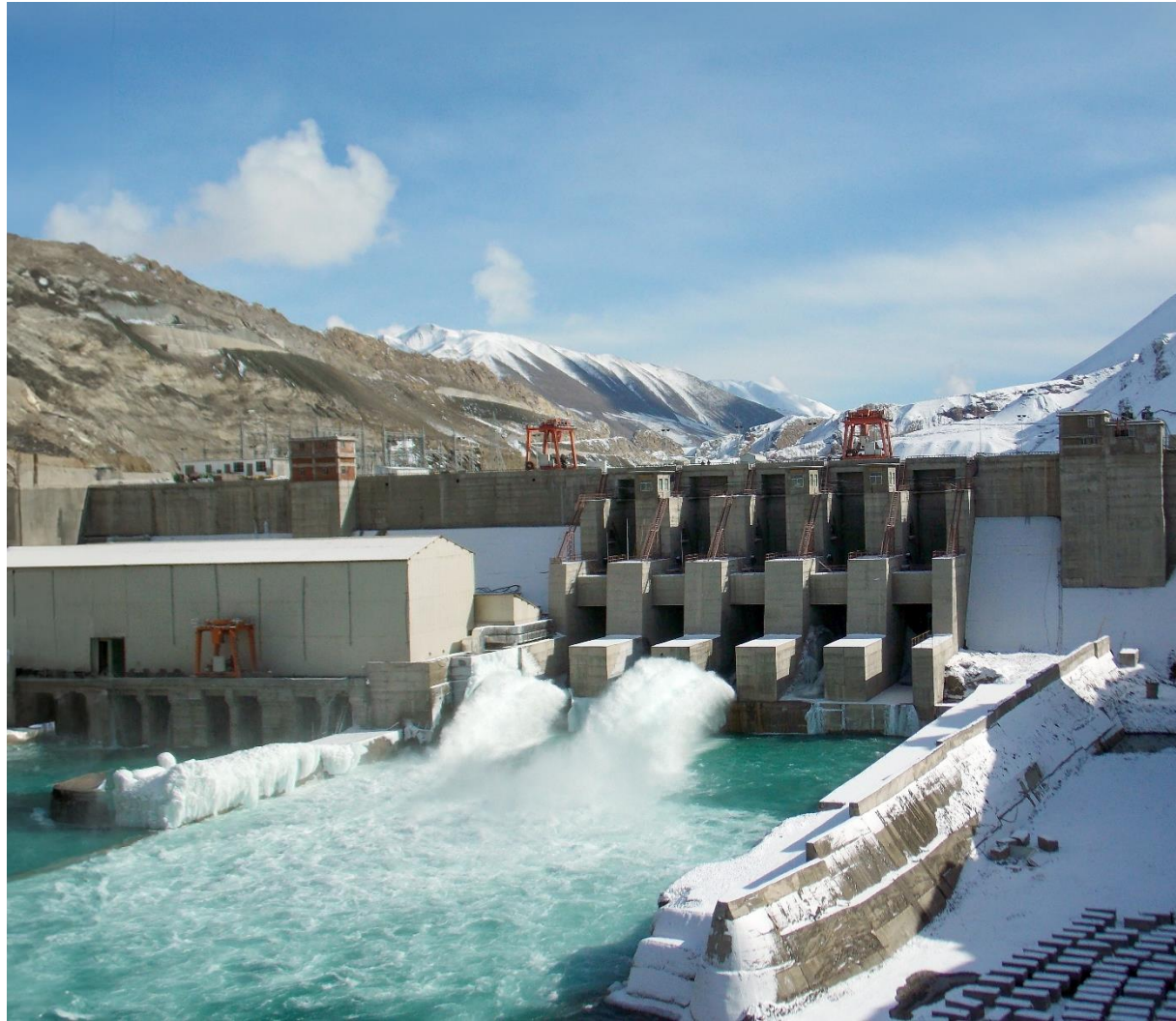
45 MW Nimoo Bazgo HEP, Ladakh
