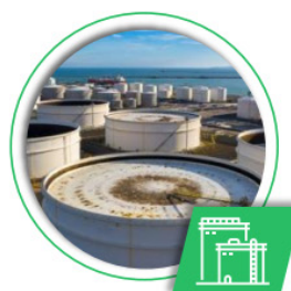
LNG / Tank Terminal
